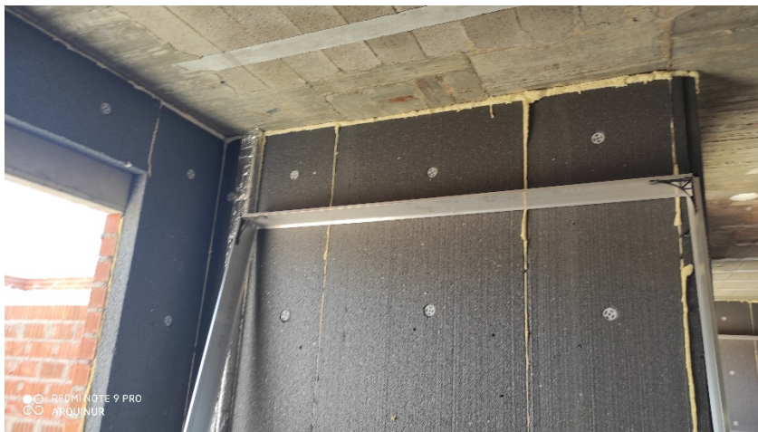
Detalle de aislamientos
