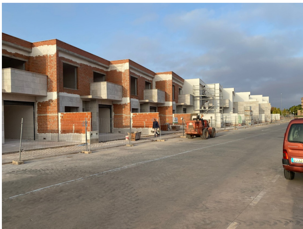
Edificio en fase de construcción
