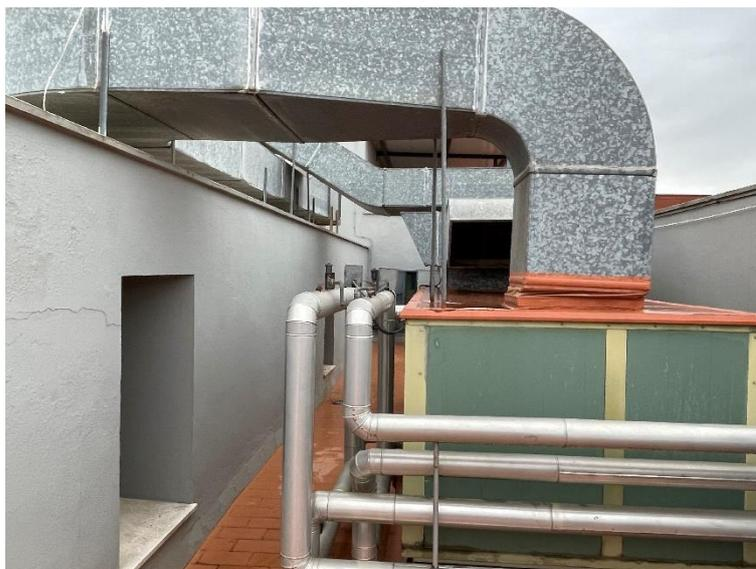
Los ventiladores eran de velocidad constante y la única capacidad de regulación eran las válvulas de 3 vías que actuaban sobre la entrada de agua en las baterías.
