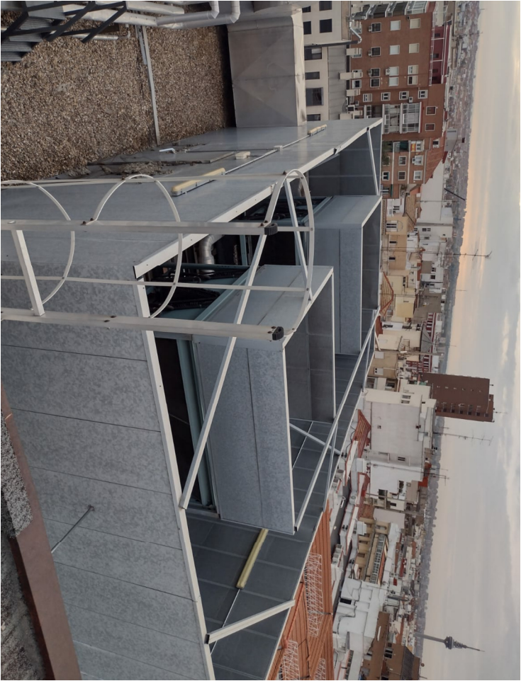
CERRAMIENTO ACÚSTICO ENFRIADORAS
