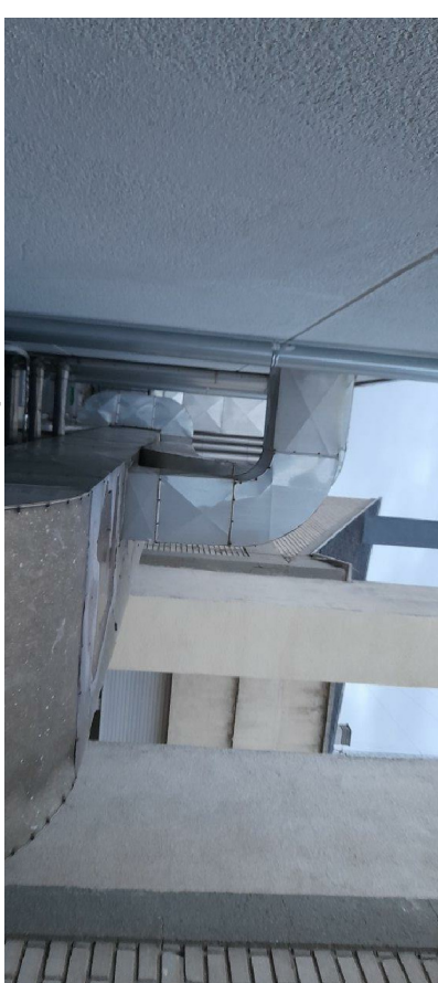
RAMALES DE IMPULSIÓN Y RETORNO HACIA PLANTA 8ª MALDONADO
