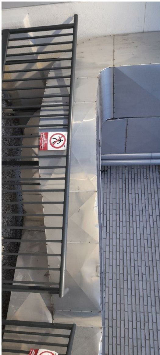
CONDUCTO DE IMPULSIÓN SOBRE CONDUCTO DE RETORNO
