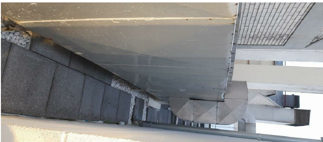
RAMAL DE CONDUCTO DE RETORNO
