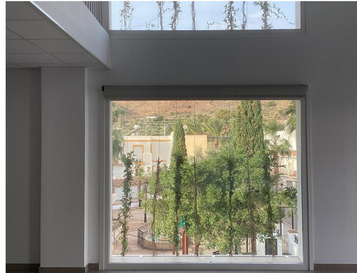
**Instalación de una fachada vegetal**, formada por anillos de jardineras distribuidas en la vertical del edificio. La plantación de vegetación trepadora genera una segunda piel al edificio que actúa como filtro frente a la alta radiación solar.
