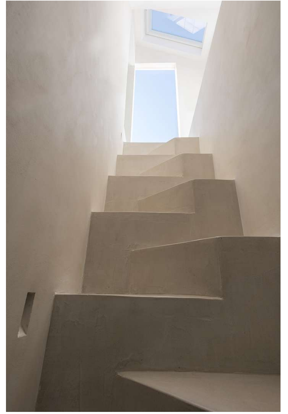
ESCALERA DE PLANTA PRIMERA A PLANTA SEGUNDA
