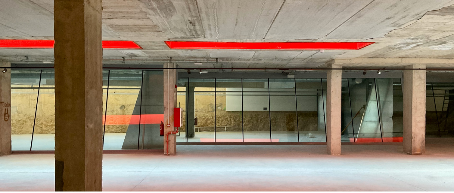
Los tabiques inclinados de vidrio cierran los espacios de aulas en el perímetro de la planta sótano.
