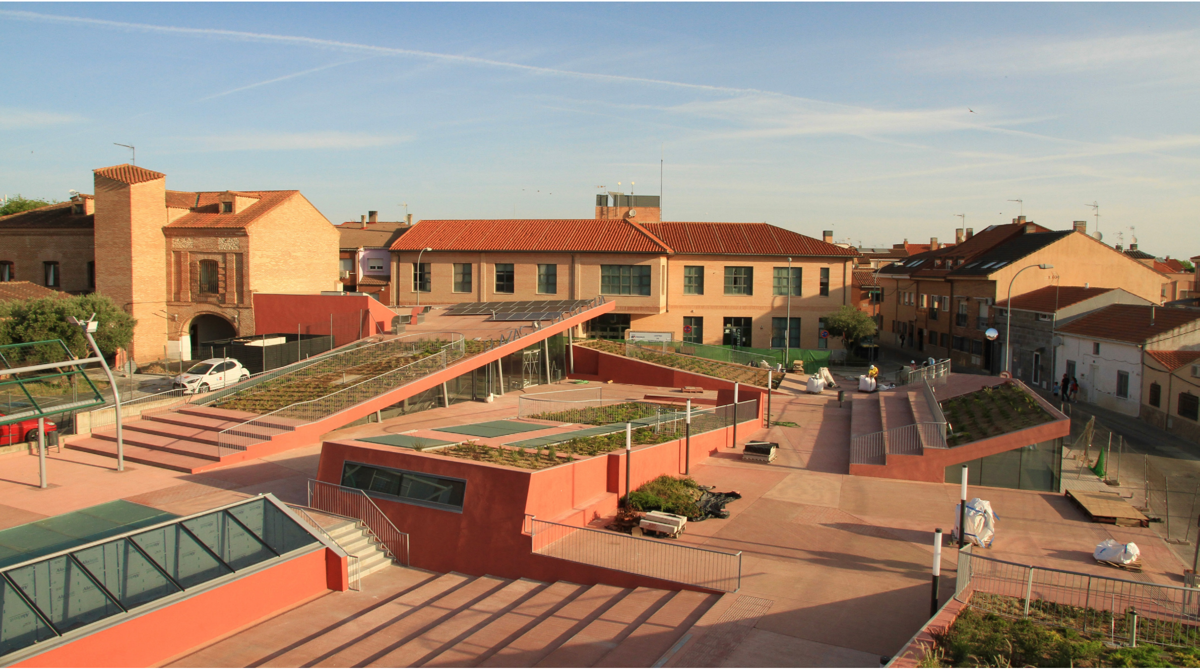
Los múltiples huecos de la construcción existente presentaban un desafío para los espacios de la plaza. Una serie de losas y volúmenes integran los accesos, la vegetación y los lucernarios a la planta baja.
