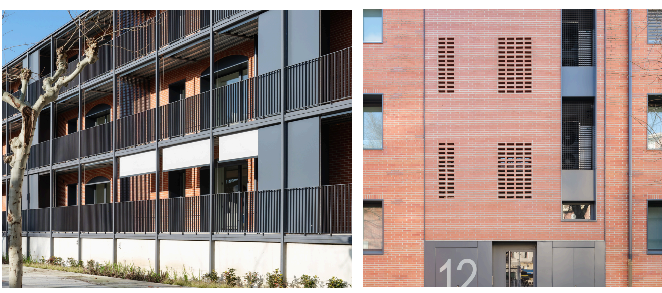
Azkarate, M. [María], (2025). Viviendas oPENLab, domótica y cuarto de máquinas en núcleo de comunicación.
