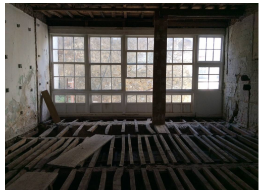
02 Obra: retirada de revestimientos
